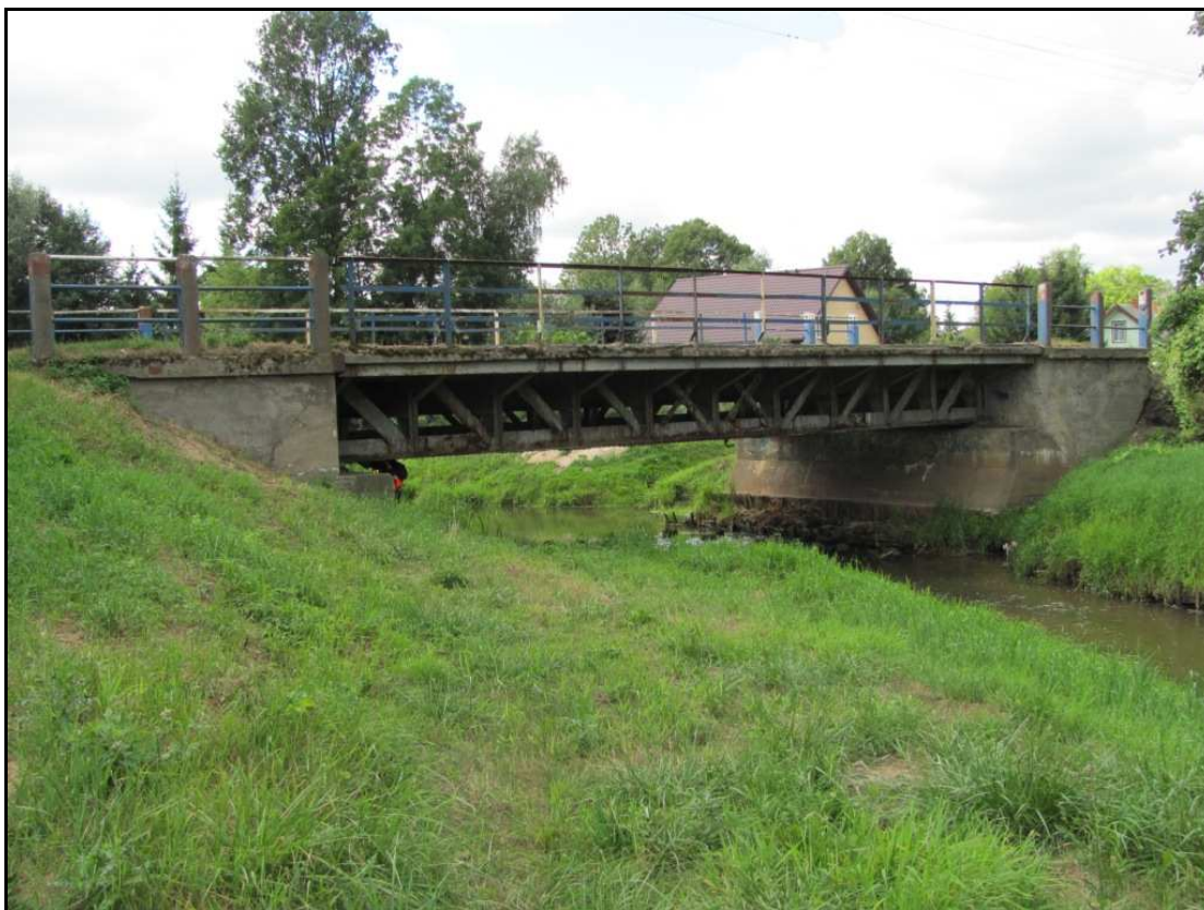
Zdj.3 Widok ogólny od strony dolnej wody.
